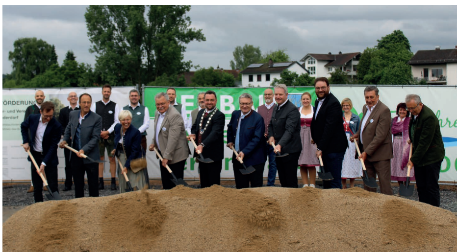
Setzen den symbolischen Spatenstich für das neue Bürger- und Vereinshaus (v.l.): Architekt Michael Feil, Bürgermeister Albert Stürmer (St. Johann a. W.), Dritte Bürgermeisterin Iris Hartmann, Zweiter Bürgermeister Helmut Kronfeldner, Erster Bürgermeister Max Höcherl, MdL Josef Zellmeier, Bezirksrat Franz Schreyer, MdL Tobias Beck, Ehrenbürger Hans Hornberger, Landrat Josef Laumer; im Hintergrund: Mitglieder des Gemeinderats, Geschäftsleiter Hans Pollmann (2. v. l.) und Architektin Anita Fischer (r.)
