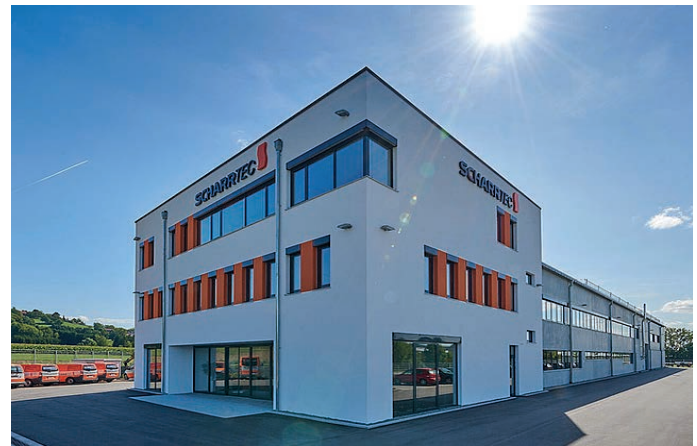
Das moderne SCHARR TEC Firmengebäude in Hunderdorf: Zentrum für innovative Wasser- und Abwassertechnik.
